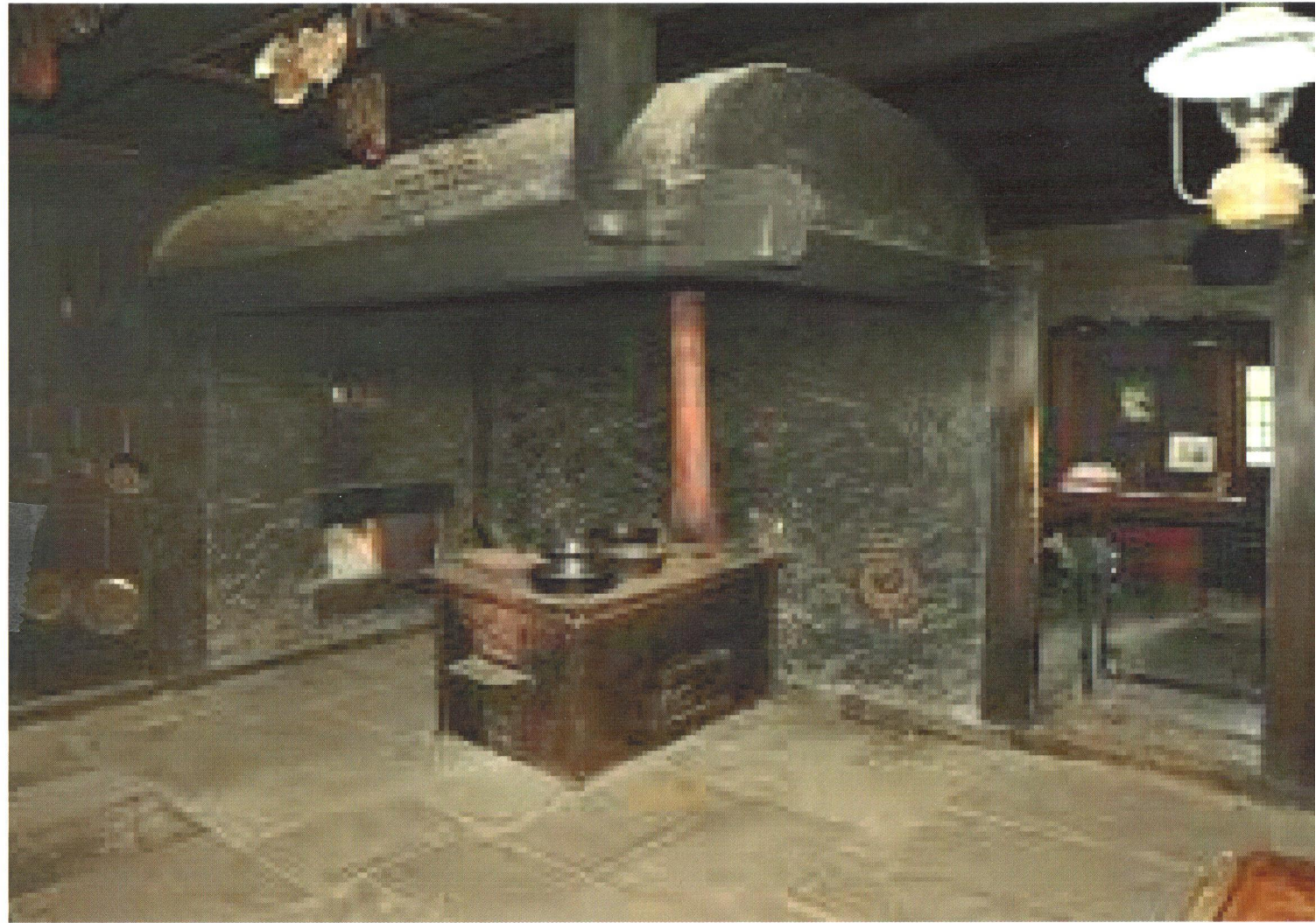
offene Feuerstätte wo die Rauchgase nur über zufällige Lücken abgeführt wurde
