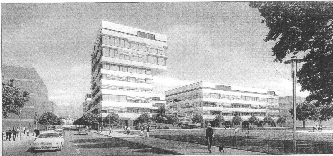
Beim Ende 2012 fertiggestellten Laborgebäude Skylabs muss achtmal pro Stunde die Raumluft ausgetauscht werden.
