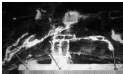
*Entfestigtes und im Verbund gestörtes Bogenscheitel-Mauerwerk – über noch herausstehende Verfüllkanülen substanzschonend verpresst und neuverfugt mit natürlich vergütetem Luftkalkmörtel 0-0,5. In der Mitte oben Ankerplatte für verzinkten Stahlanker. Auch Ankerkanal verpresst mit Luftkalkmörtel.*
