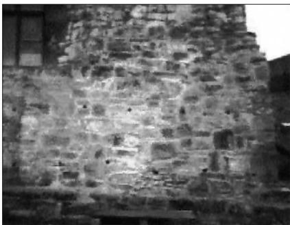
*Hohles Burgmauerwerk. Verfugt und verpresst mit salzarmem und elastischem Luftkalkmörtel. In Bildmitte zweireihige Auslässe der Verfüllstutzen.*
