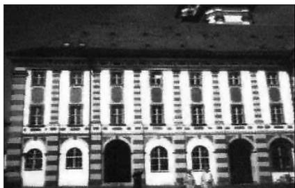
*... dennoch zur Wiederverwendung geeignet als Untergrund für neuen Putzaufbau mit Luftkalkmörtel, nach Erstbefund gestrichen mit Kalkkaseinfarbe in tagwerksge-rechter Freskotechnik:*
