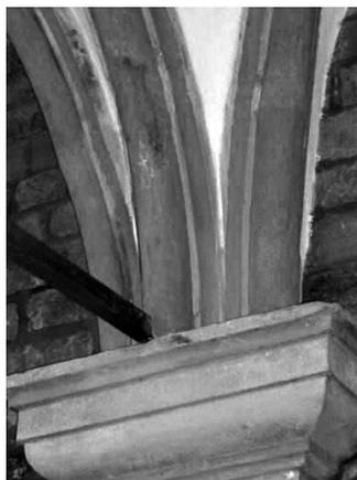
*Eisenanker nach Reparatur – Teilergänzung verrosteter Bereiche und traditionellem Rostschutz (Bleimennige in Leinöl, Glimmerfarbe in Leinöl-Standöl), nun in elastischem Kalkmörtel eingebettet.*
