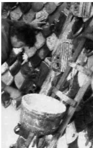
*Instandsetzung und Neuvermörtelung der Grate mit Luftkalkmörtel<sup>17</sup>*
