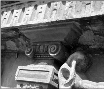
*Scheußlich, was Nässe durch Wasserglas alles am Oberkirchner Sandstein, Deutschlands erste Qualität, anrichten kann. Eine pigmentierte Kalktünche schützt nun vor weiterer Verwitterung – Muster am Kapitell. Sie zerkrustet, zersalzt und zerfeuchtet die Fassade nicht. Im Unterschied zu den – trotz mancherlei Diffusionsfähigkeit – kapillartrocknungsblockierenden und deswegen fassadenzerstörenden synthetischen Farbzepturen moderner Bauchemie.*
