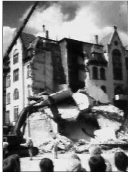
*Jena, „Sanierung“ des spätgotischen Roten Turms mit modernen Methoden. Unter den Betondecken liegen 4 tote Handwerker – trotz Prüfstatik.*
