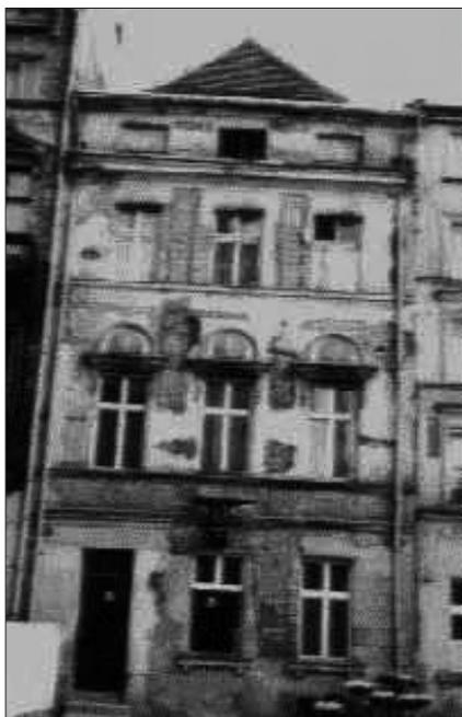
Thorn. Durch übertriebene „Bauarchäologie“ zerstörte Originalfassade des 19. Jhs. über älteren Fragmenten
