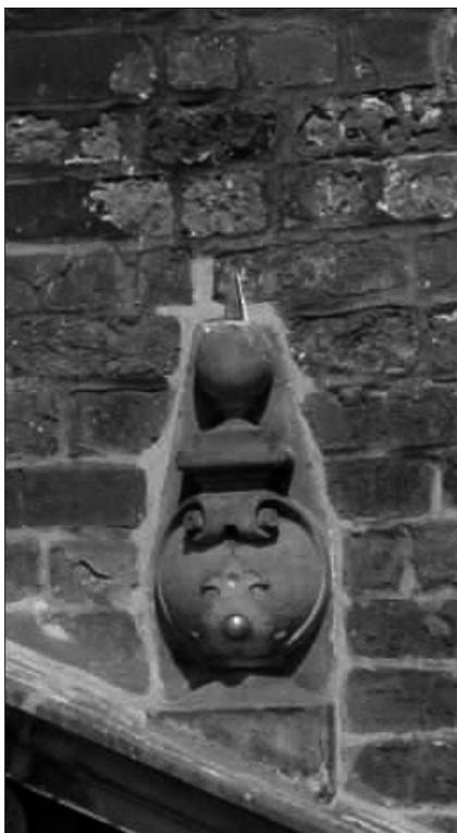
*Mauerwerk der Musterachse: Zerstörungsgrad und Reparaturbereich direkt über dem Fenstergiebel mit preisgünstigster Kalkmörtelergänzung auch im Backsteinbereich. Es muss nicht immer nachgeschnittenes Gold sein, nur damit sich die Restaurierhelden darin sonnen können!*
