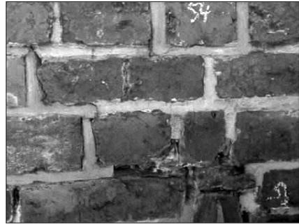
*Die alten mauerwerkszerstörenden, gerissenen und kapillarsaugenden Zementfugen blieben überwiegend (kosten- und denkmalsubstanzsparend) drin! Ihre wassersaugenden Löcher und Risse wurden allerdings mit Luftkalkmörtel harmlos geschlossen. Alle Steine wurden begutachtet und nur, wo technisch notwendig, repariert. Man sieht die Kartierung aus Kreidebezeichnung.*
