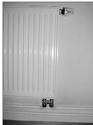
*Temperierrohre und Strahlplatte über der Sockelleiste 6 Jahre nach Einbau.*
