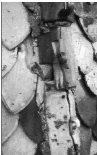
*Ravensburg, Grüner Turm mit gotischer Glasurziegeldeckung. Zerstörung der Flächen- und Gratziegel durch zu starre, dichte und schadsalz haltige zementäre Dachdeckermörtel.<sup>16</sup>*
