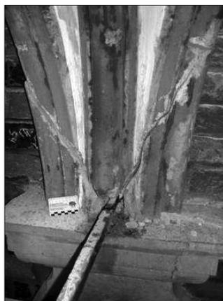
*Einzementierte korrodierte Eisenanker, deren gesamtes Schadensbild und die daraus abzuleitenden Maßnahmen nur nach Freilegung im Musterachsenbereich ausschreibungs- und kostenkontrollfähig wurden.*
