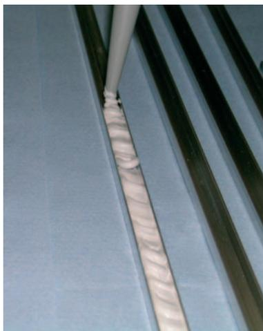
**Bild 5:** Einbringen einer Dichtungsmasse in eine Aluminium-U-Profilsschiene
