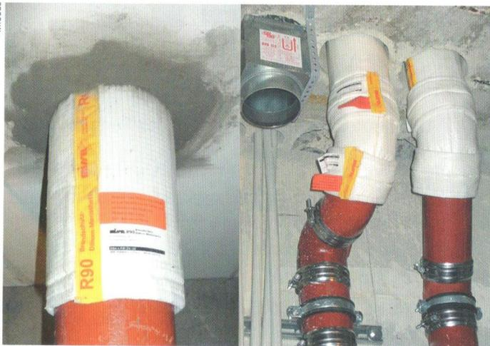
Brand- und Schallschutz Dämm-Manschetten von Missel.
