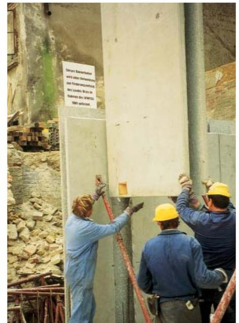
Bild 1: Neben den Schalsteinen für kleinere Bauvorhaben und Stahlbeton werden vermehrt großformatige Stahlbeton-Fertigteile für den Kellerbau eingesetzt (Foto: Firma Katzenberger)
