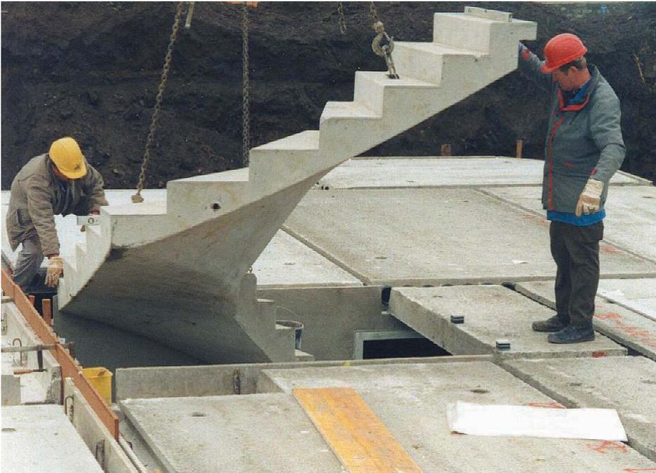
Bild 2: Üblicherweise wird die Hauptstiege eines Gebäudes über der Kellerstiege angeordnet. Das erforderliche Steigungsverhältnis ist in den Landesbauordnungen festgelegt. (Foto: Firma Maba)
