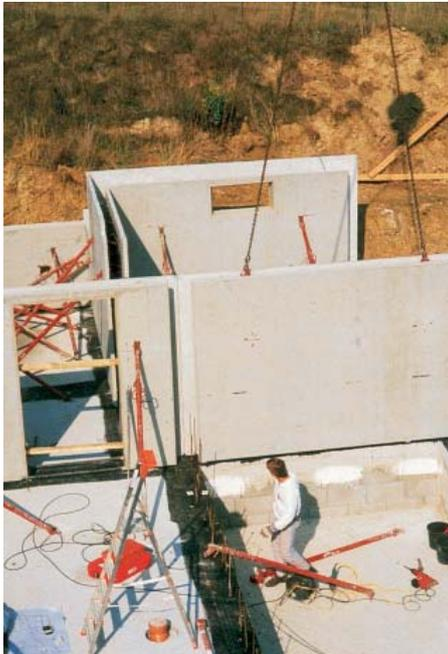
Bild 4: Passgenaues Einrichten der Doppelwandelemente ist eine Voraussetzung des raschen Baufortschrittes (Foto: Firma Katzenberger)
