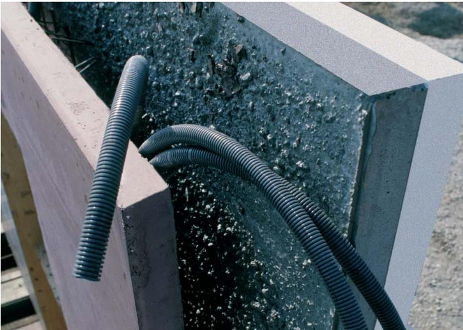
Bild 6: Zum Erzielen eines ausreichenden Wärmeschutzes bei beheizbaren Kellerräumen können Hohlwandelemente mit schon aufgebracht außen liegender Wärmedämmung eingesetzt werden (Foto: Firma Oberndorfer/Werbeagentur Herzog, Linz)
