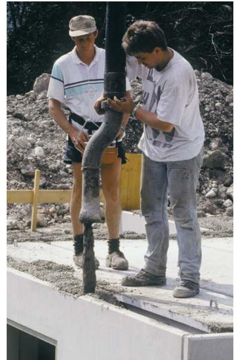
Bild 5: Nach dem Einbau des Rostes werden die Hohlwandelemente mit Frischbeton ausgegossen (Foto: Firma Oberndorfer/Werbeagentur Herzog, Linz)
