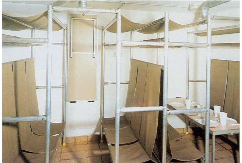
Bild 9: Der Raumbedarf eines Schutzraumes ergibt sich aus der Anzahl der notwendigen Schutzraumplätze, dem nötigen Luftbedarf sowie dem Platzbedarf für Toilette, Waschgelegenheit, Lüftungsanlage sowie Vor- und Nebenräume (Foto: Firma Krobath)
