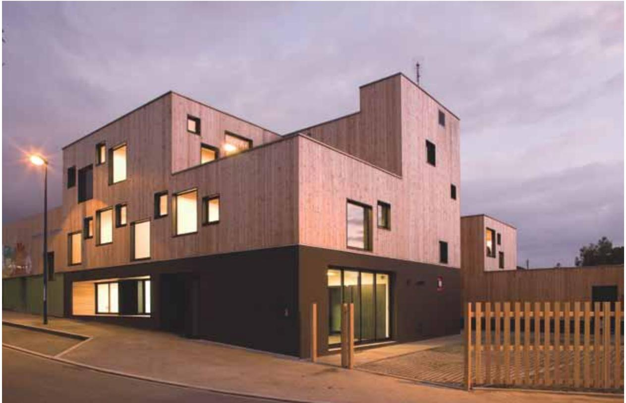
BBS Elemente erfüllen alle Kriterien einer massiven Bauweise, sie erreichen den Feuerwiderstand REI 30-90, können lastabtragend eingesetzt werden und erhöhen die speicherwirksame Masse eines Gebäudes.
