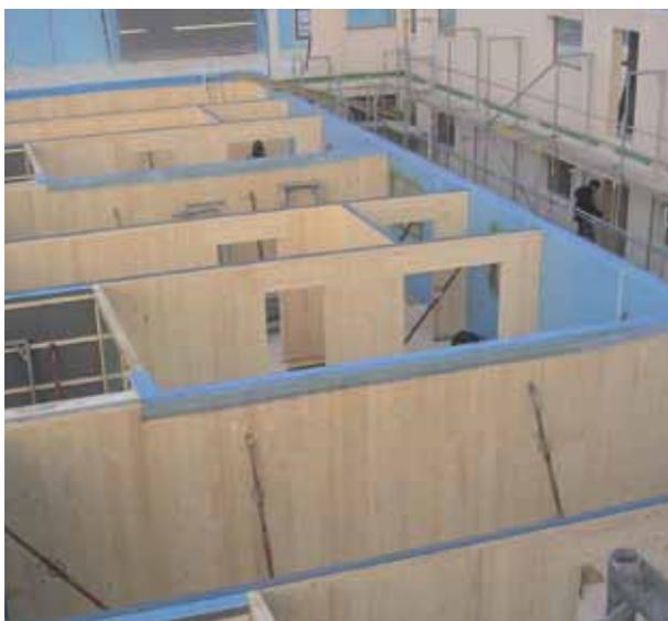
dämmung von Bauteilen ist eine möglichst geringe Nebenweg-Übertragung anzustreben. Für die Beurteilung des Schallschutzes ist die Bausituation maßgeblich, d. h. bei den schalltechnischen Anforderungen wird ein trennender Bauteil immer inklusive der Nebenwege beurteilt. Nur bei Einhaltung der Verarbeitungsregeln und Berücksichtigung der Anschlussdetails können angegebene Schalldämmmaße erreicht werden.
