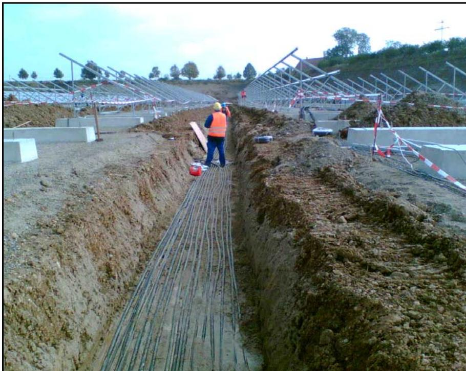
**Abb. 2-2: Beispiel für die Verlegung der Kabel im Kabelgraben**
